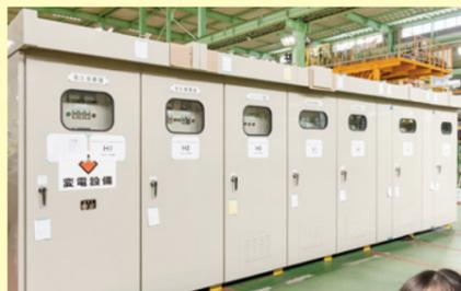
高い電圧を施設で使える電圧にする機械を収めた箱を「キュービクル」と言います。ブレーカーや変圧器などたくさんの機械が入っています！
